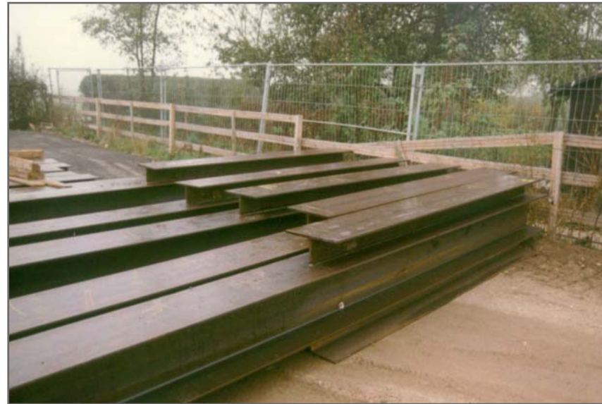
Tension piles Bremen (D)
