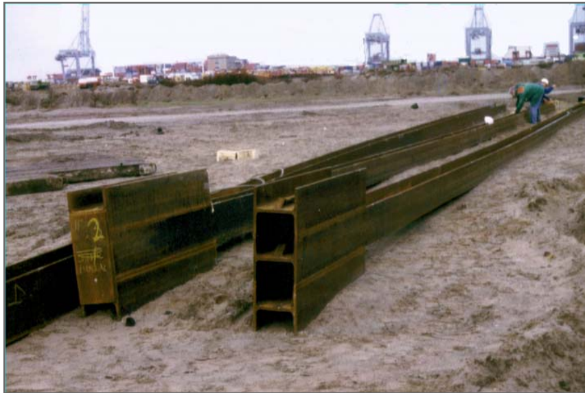
Compression piles Maasvlakte – Rotterdam (NL)
