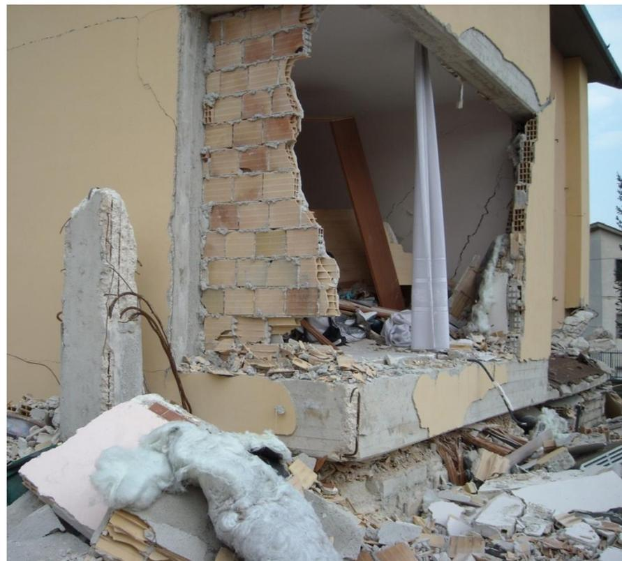
Meccanismo fragile di piano causato dalla rottura a taglio dei pilastri del primo livello.
