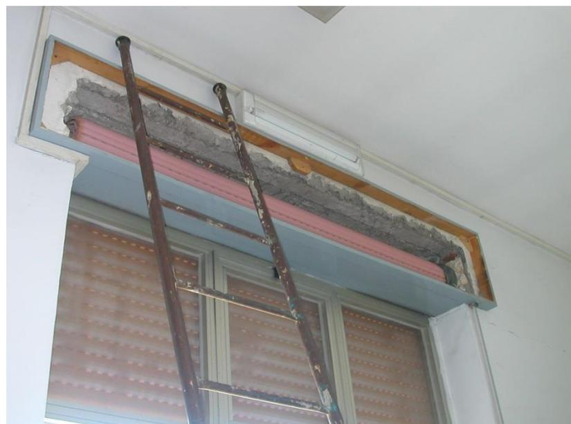
Saggi sul solaio finalizzato all'individuazione della tipologia strutturale e degli spessori (ove necessario anche delle armature)
