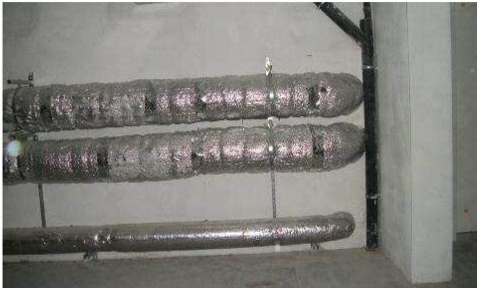
Le linee di adduzione devono essere protette con **adeguato rivestimento antifuoco** per mantenere nel tempo la capacità di trasporto dell'aria necessaria al mantenimento della pressurizzazione.
