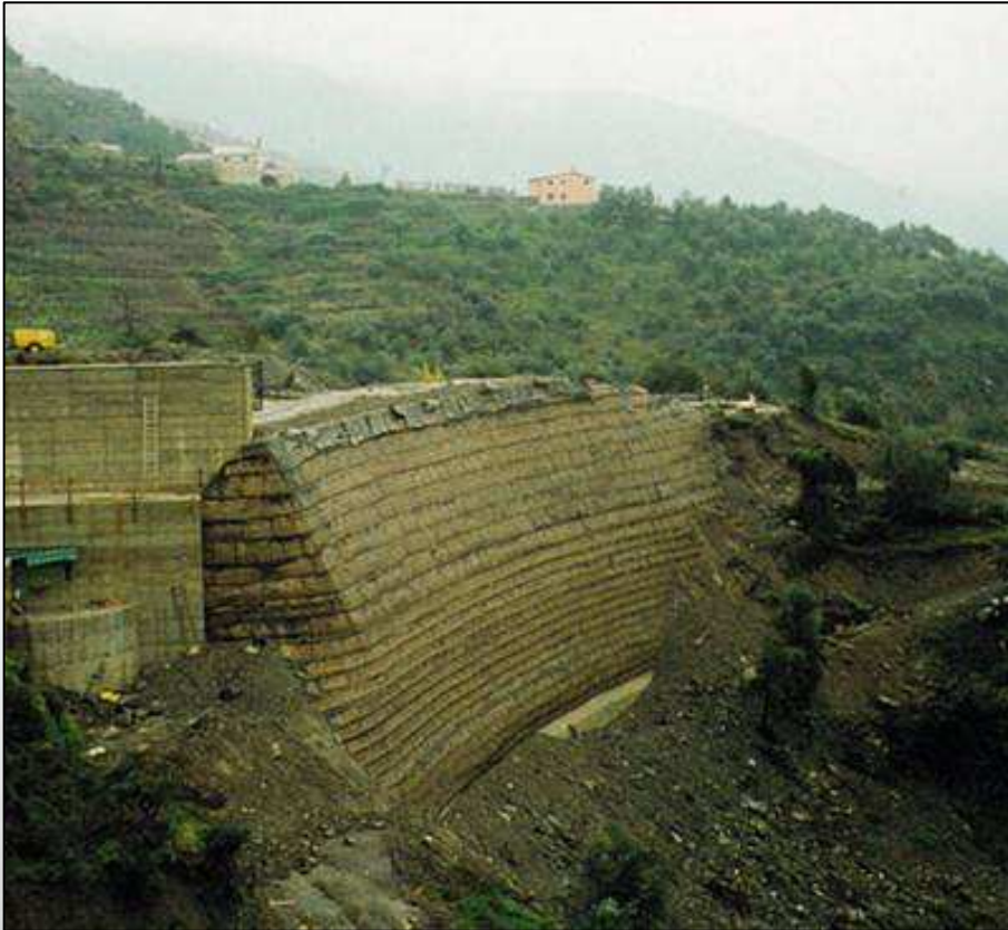
Muro d'ala di accesso ad un cavalcavia
