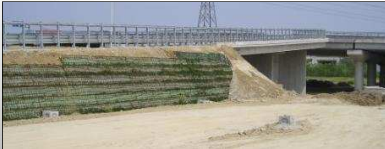
Rampa di svincolo con sistema Tenax River
