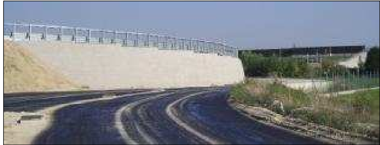
Rampa di svincolo con sistema Muro Forte
