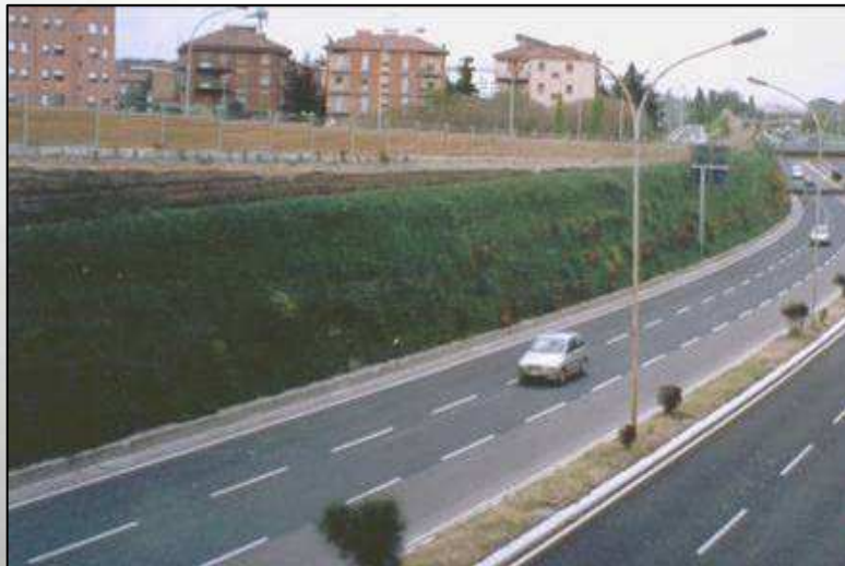
A14 Bologna: barriera fonoassorbente in trincea
