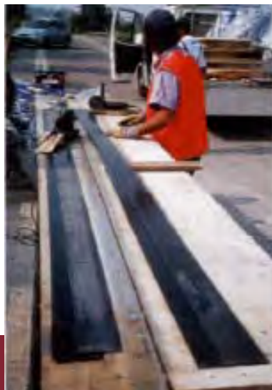
Taglio in opera di lamine prefabbricate
