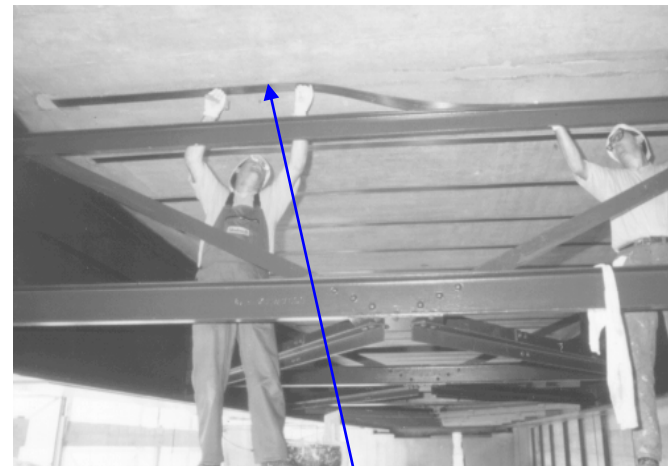
Rinforzo di un impalcato da ponte con lamine
