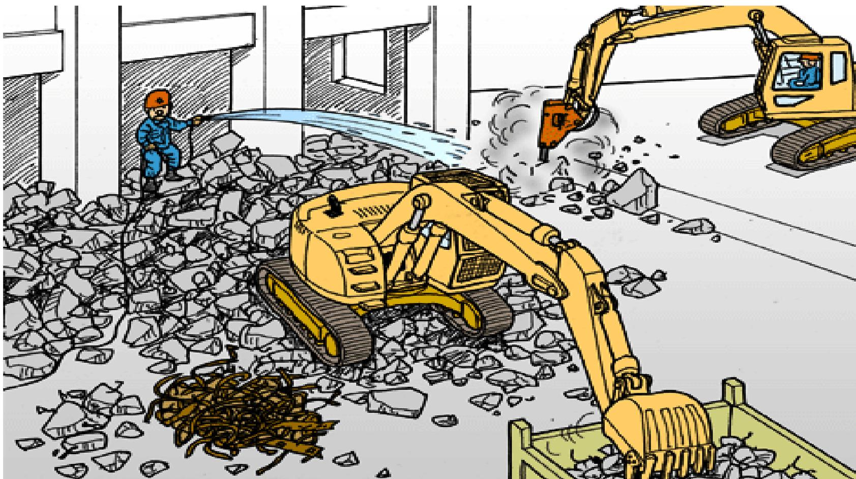
**Guardate cosa è successo!** Il tubo dell'acqua utilizzato dal lavoratore è rimasto incastrato in qualcosa ed il lavoratore si è spostato dentro il raggio di azione della pala meccanica per disincastrarlo. Il lavoratore è rimasto colpito dalla pala meccanica.
