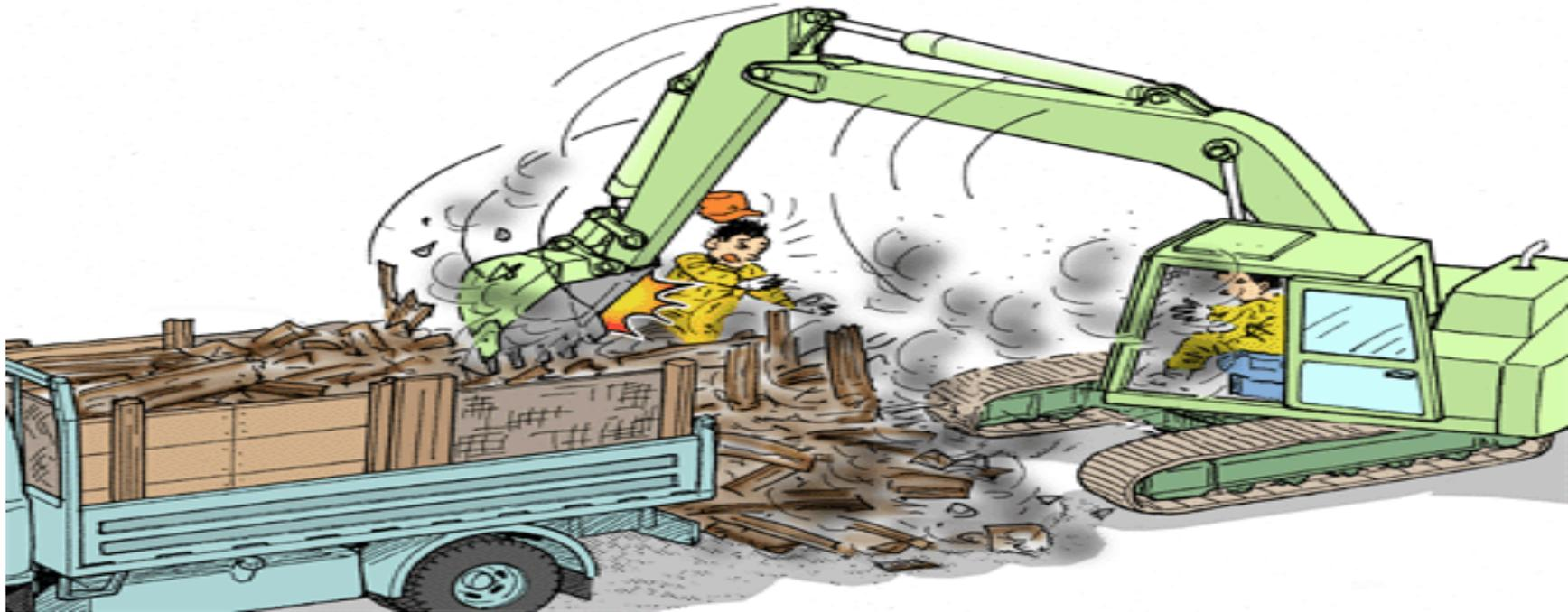
**Consigli** 1. Non stare nel raggio di azione del mezzo. 2. Nei lavori che producono polvere chiudere la porta ed i finestrini oppure indossare occhiali di protezione 3. Limitare la polvere anche mediante bagnatura dei detriti.
