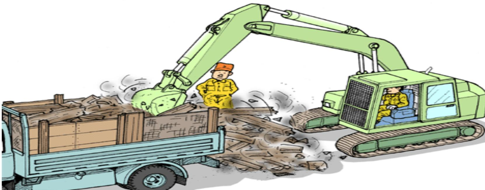
**Guardate cosa è successo!** Nello scaricare i detriti si è generata una nube di polvere che ha investito la cabina dell'operatore della pala. Quest'ultimo nel proteggersi gli occhi ha inciampato nelle leve di controllo facendo ruotare la pala che ha colpito l'altro lavoratore
