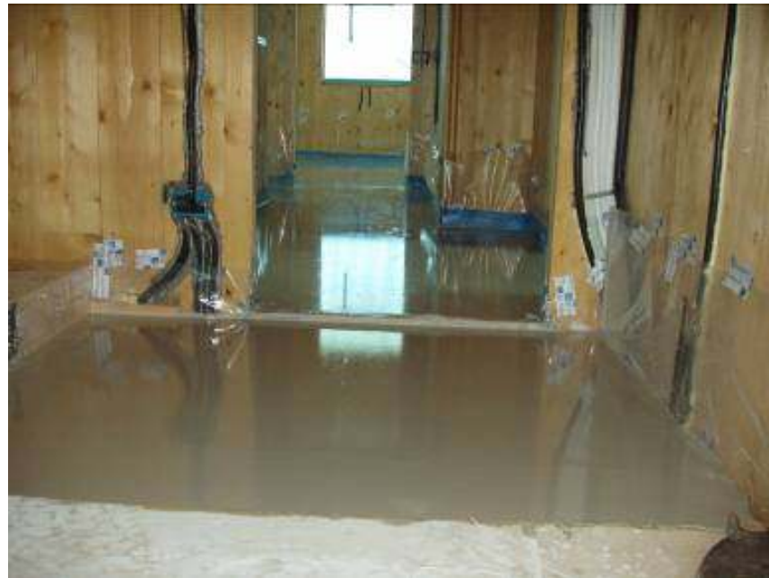
Solai gettati: massetto cementizio e in anidrite.
