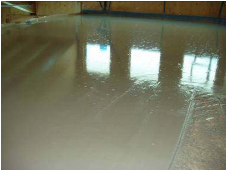
Solai gettati: massetto cementizio e in anidrite.
