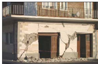
Fessurazione diagonale per trazione
