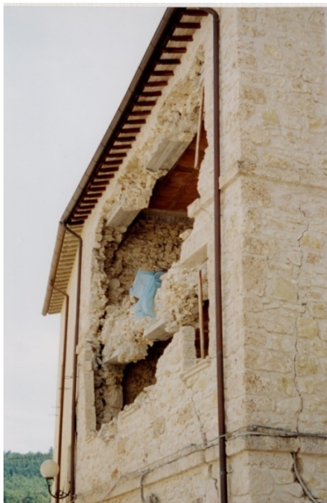
deviazione delle isostatiche di compressione
