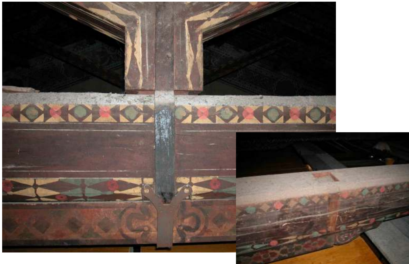
Unione monaco-catena nascosta (a tenone e mortasa)
