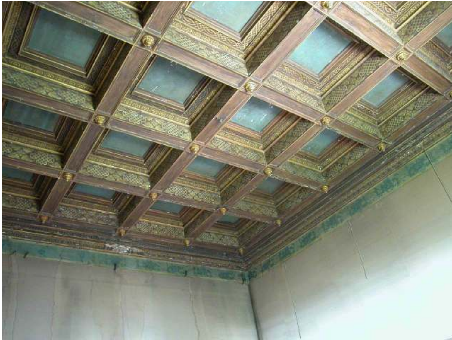
Solai con struttura “a cassettoni” (Villa)
