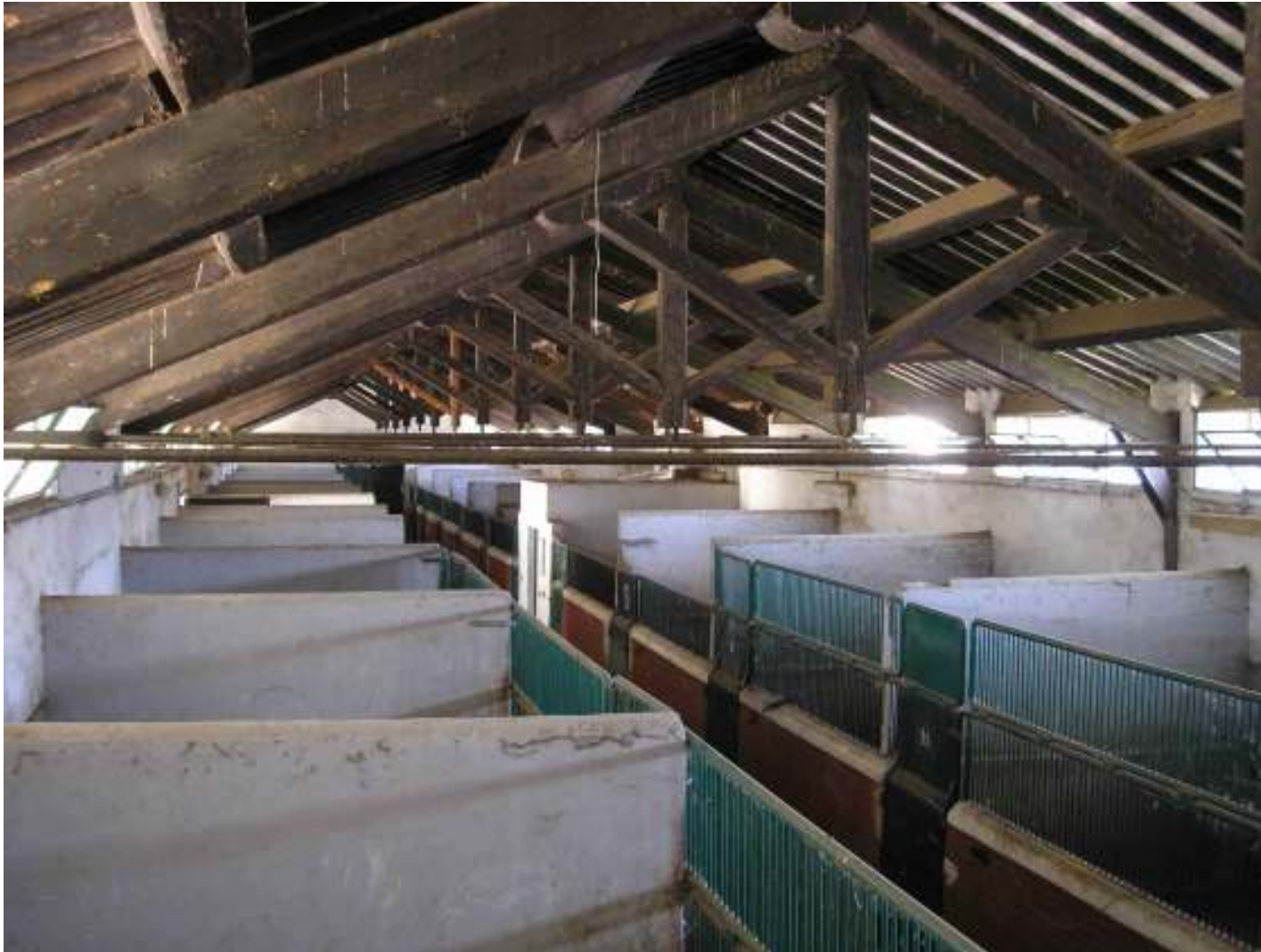
Capriate con catena metallica (scuderia)
