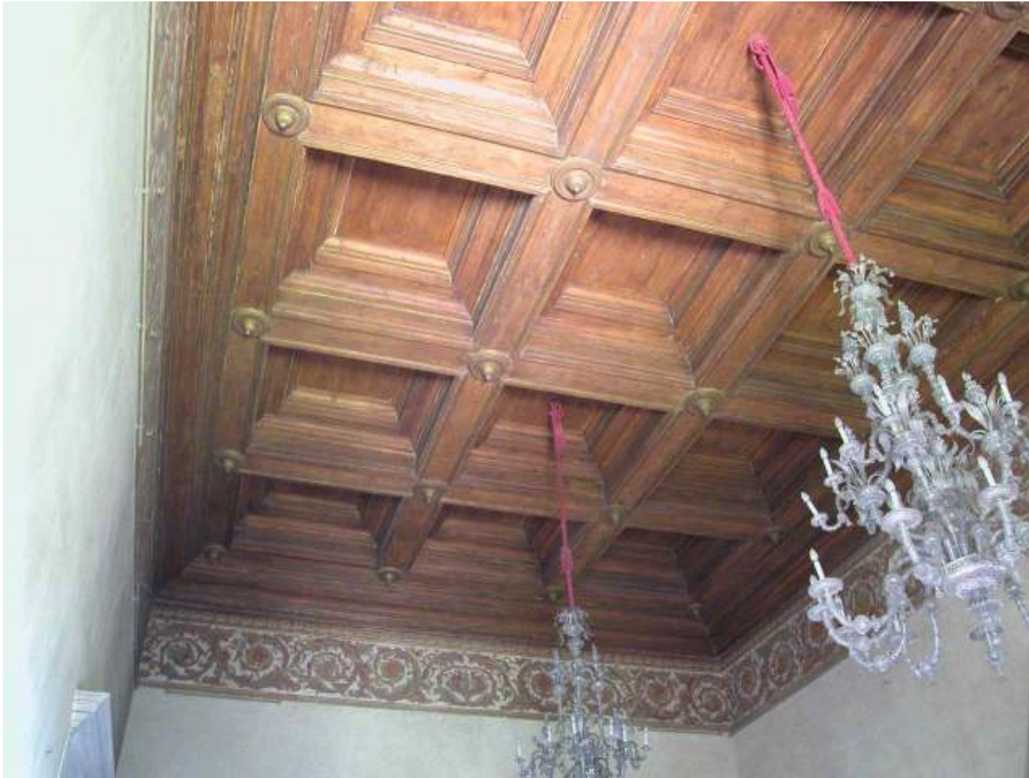
Solai con struttura “a cassettoni” (villa)
