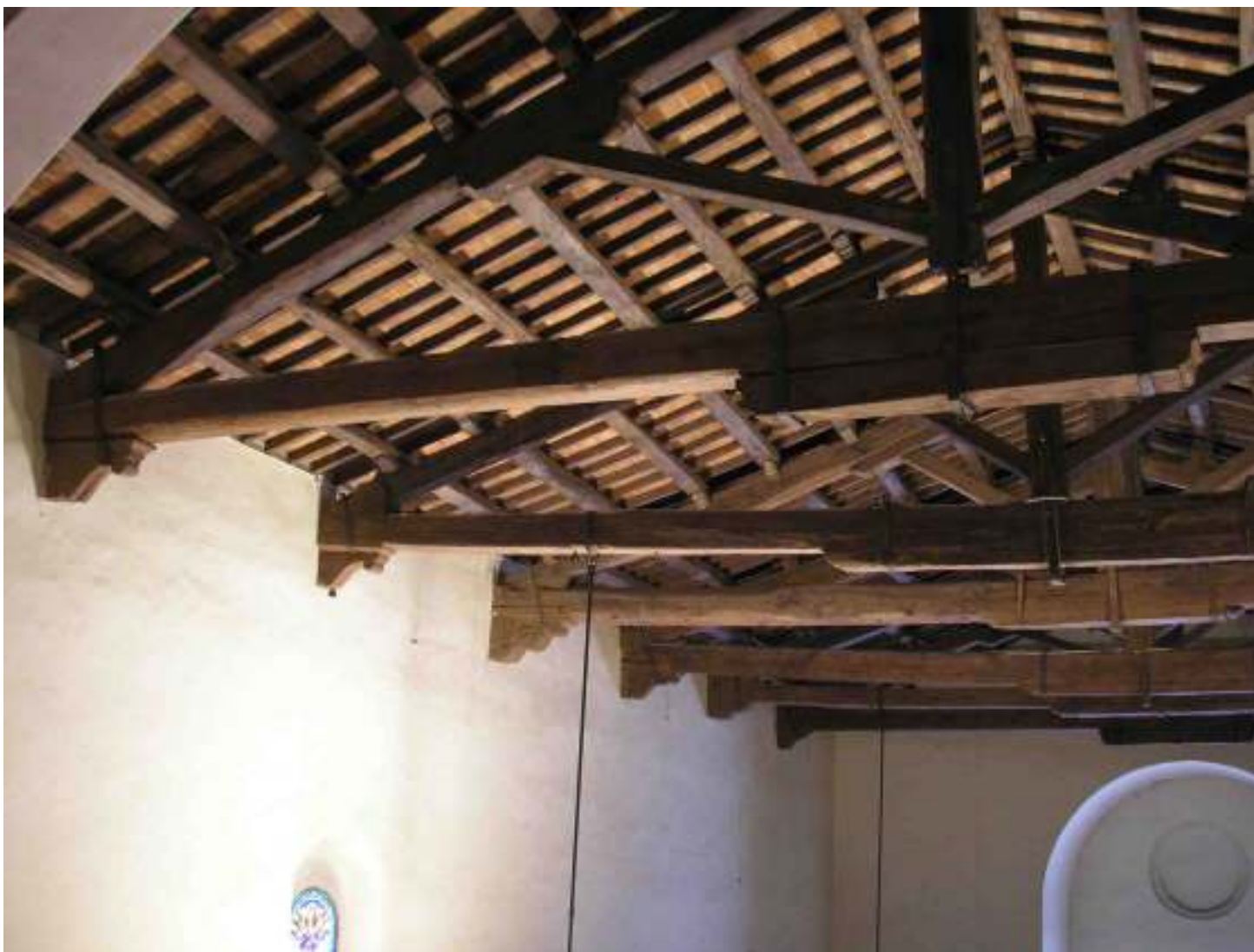
Struttura a capriate non decorata (chiesa)
