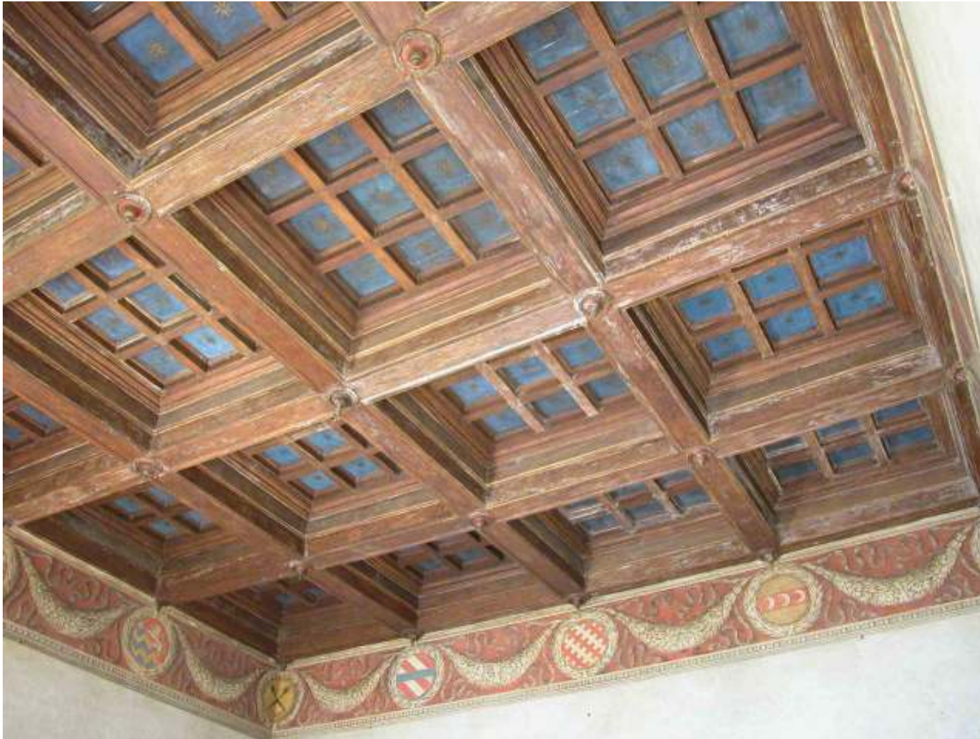
Solai con struttura "a cassettoni" (Villa)
