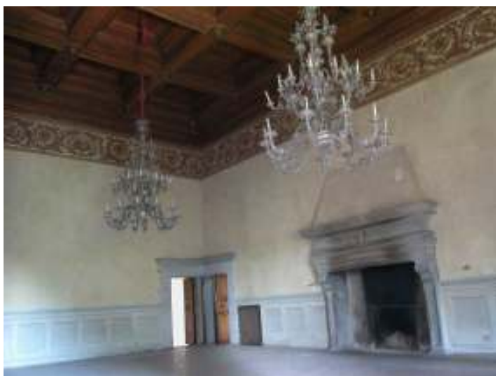
Solai con struttura "a cassettoni" (Villa)
