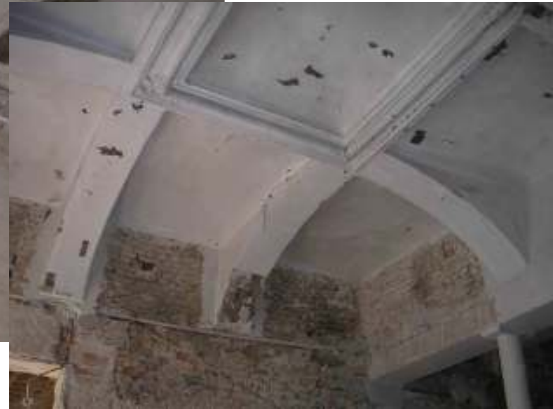
Solaio con orditura a travi e voltine di muratura (palazzo)
