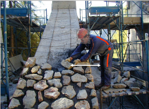
La movimentazione manuale dei carichi in cantiere
