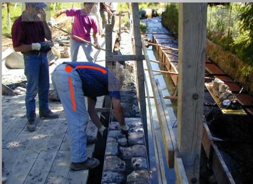
La movimentazione manuale dei carichi in cantiere
