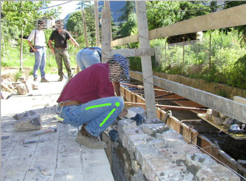
La movimentazione manuale dei carichi in cantiere
