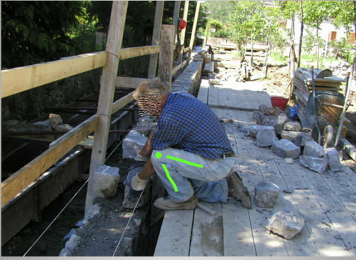
La movimentazione manuale dei carichi in cantiere
