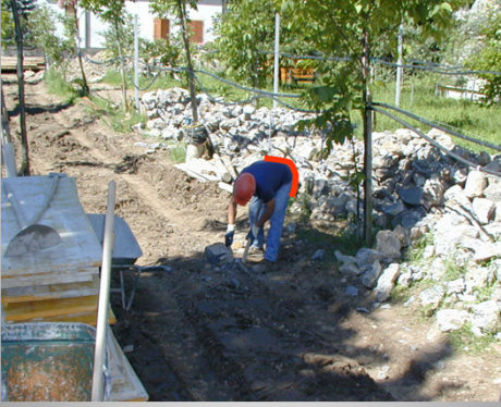
La movimentazione manuale dei carichi in cantiere
