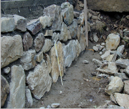
La movimentazione manuale dei carichi in cantiere
