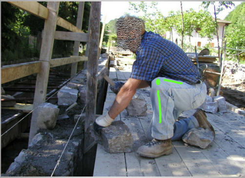
La movimentazione manuale dei carichi in cantiere
