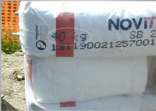
La movimentazione manuale dei carichi in cantiere
