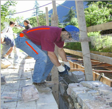
La movimentazione manuale dei carichi in cantiere
