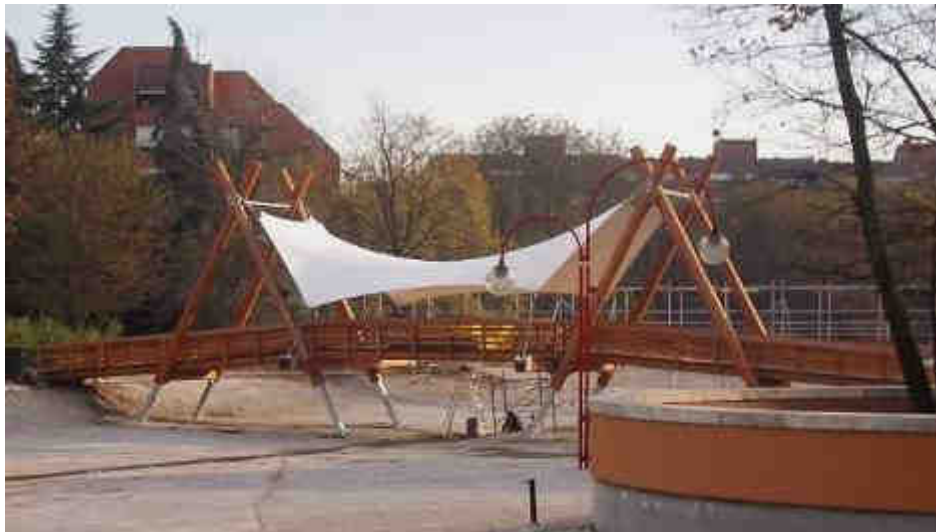
Ponte pedonale a Milano 3 in legno massiccio di larice (2004)
