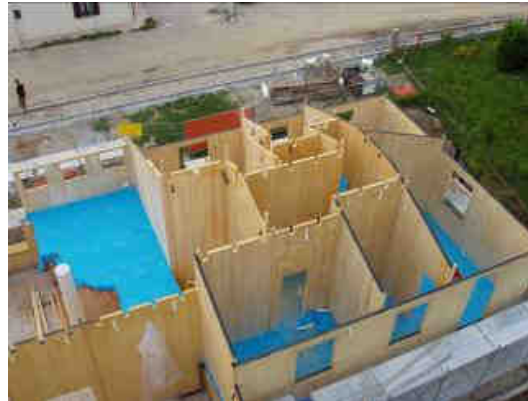
PANNELLI setti portanti incollati q=2 (3)
