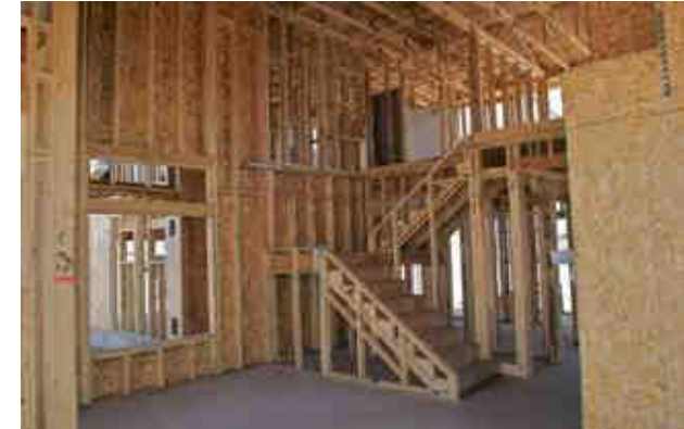
TELAIO E PANNELLI setti portanti chiodati q=5
