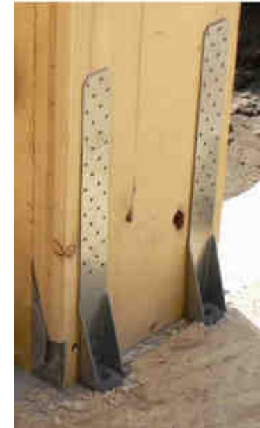
Angolari, Holddown, viti e chiodi ad aderenza migliorata
