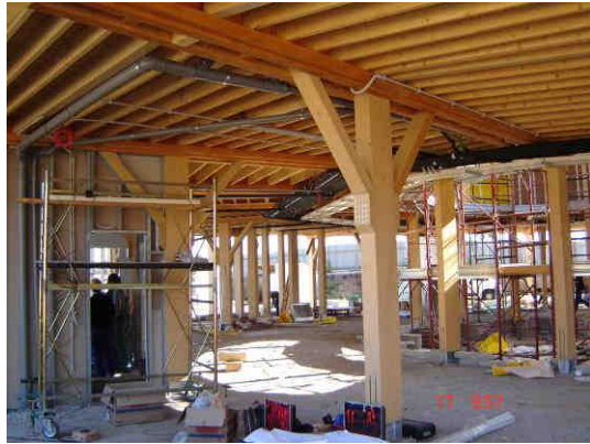
TELAIO travi, pilastri, controventi, saette q=2-4
