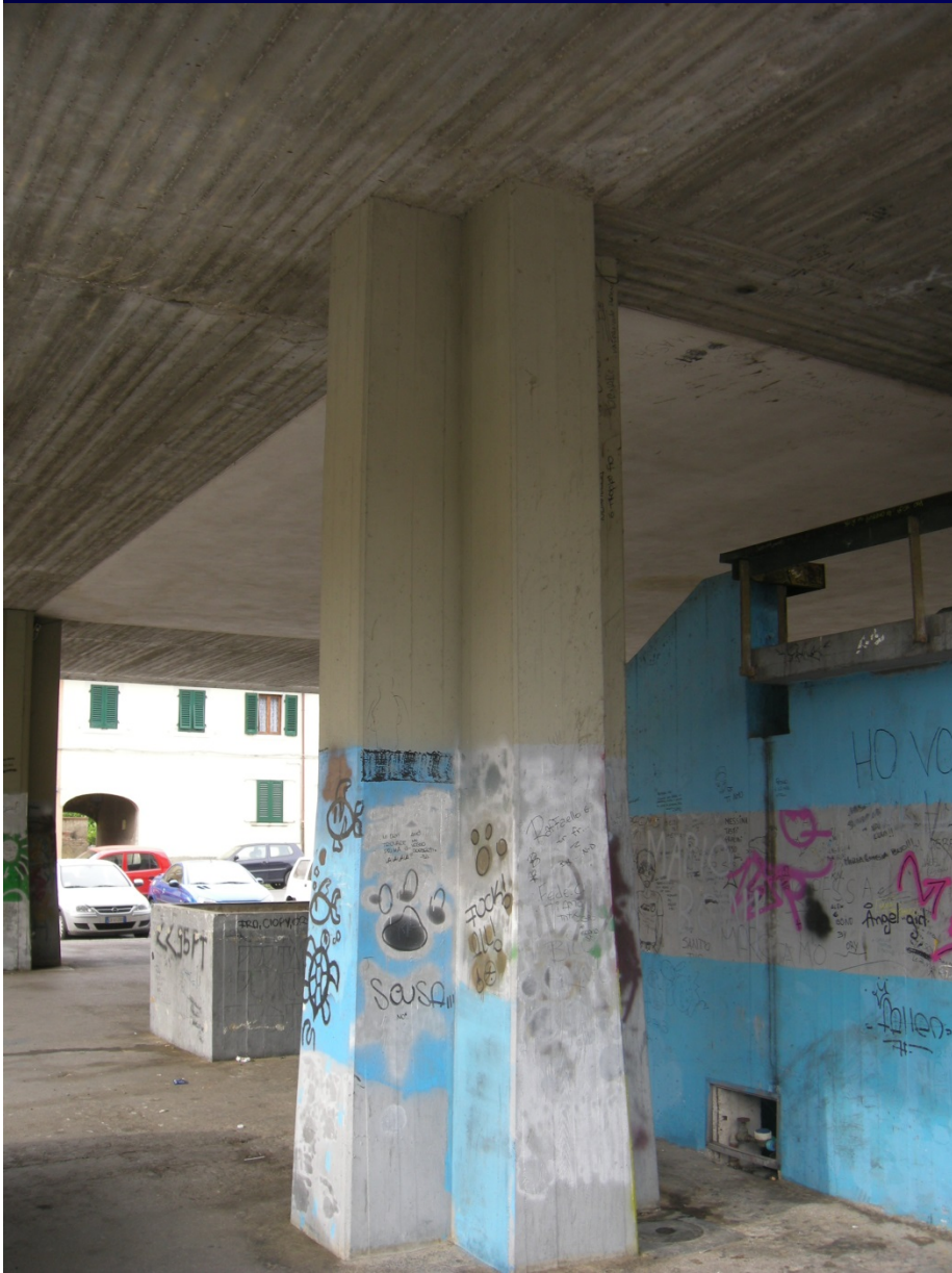
Vista dei pilastri con sezione cruciforme
