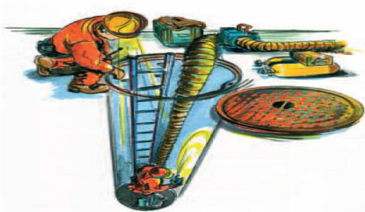
Figura 9: Le persone entrate in pozzi, fosse e canalizzazioni sono sorvegliate dall'esterno. Al verificarsi di situazioni d'emergenza o nel caso di un incidente l'addetto alla sorveglianza dà immediatamente l'avvio alle operazioni di salvataggio.
