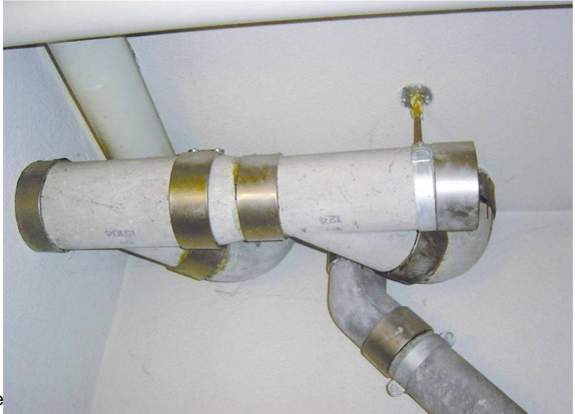
**Condutture in cemento-amianto**
