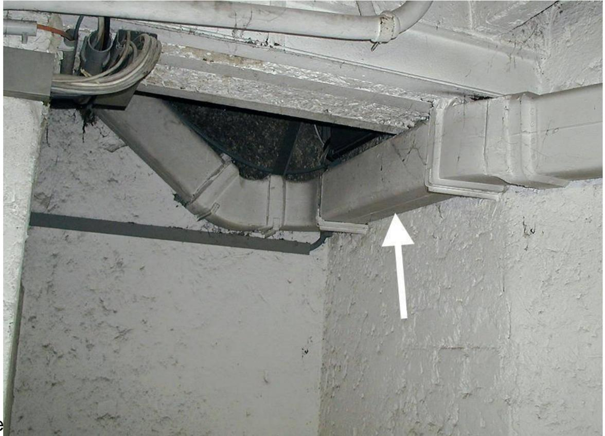
**Canali di ventilazione in cemento-amianto**
