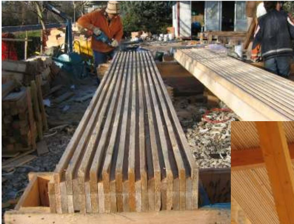
Solai a pannelli di tavole chiodate, realizzati con lamelle a “pettine” H= 120 e 150mm. luce 5.00m
