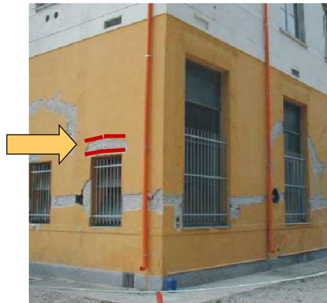
I rilievi di tipo visivo sono effettuati ricorrendo a rimozione dell'intonaco e saggi nella muratura che consentano di esaminarne le caratteristiche in superficie e nello spessore murario e l'ammorsamento tra muri ortogonali e dei solai nelle pareti. Si distinguono:
