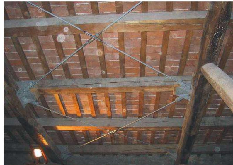
I solai vengono poi **ancorati** alle pareti per **evitare lo sfilamento** delle travi, e per svolgere un'azione di **distribuzione** delle forze orizzontali e di contenimento delle pareti. I collegamenti possono essere effettuati in **posizioni puntuali**.
