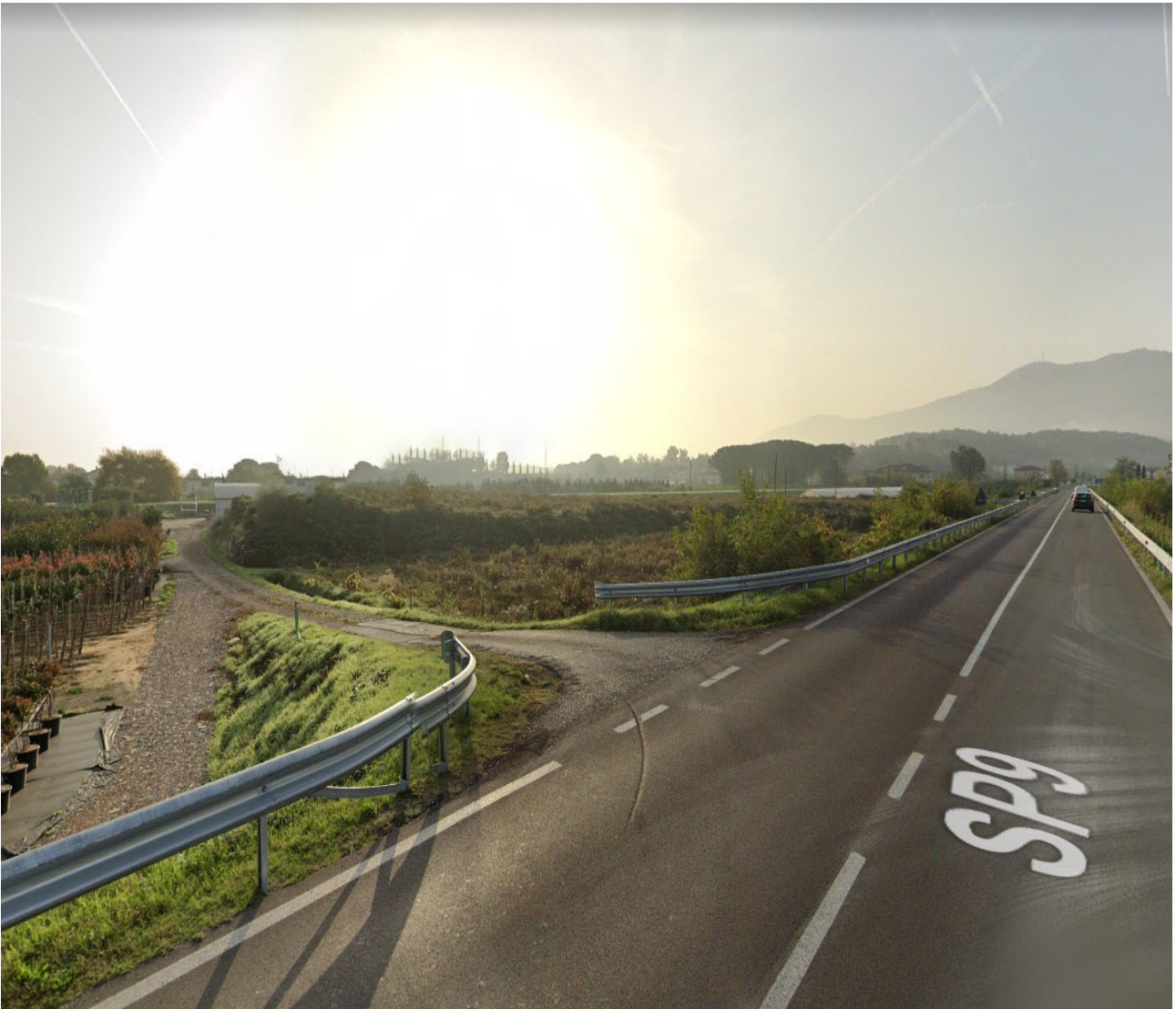
Vista dell'area d'ingresso al lotto - stato attuale
